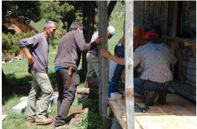
Figure 2 : La force des collectifs : éleveurs travaillant à la réfection d'un logement
